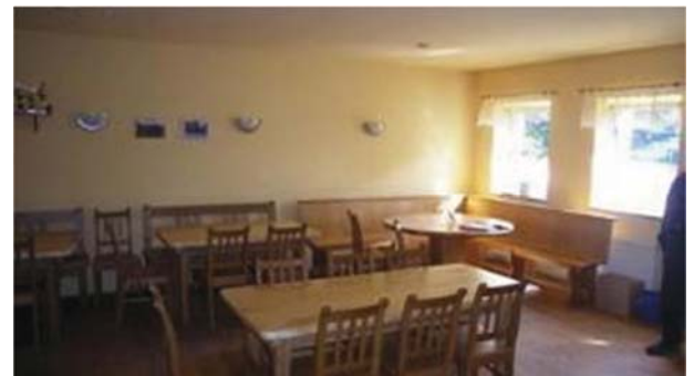
Heizkörper teilweise verstellt
